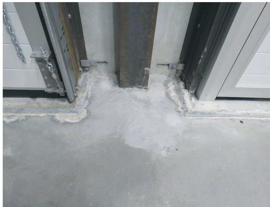
▲ Geen krimp scheuren rondom bijvoorbeeld stalen kolommen.
