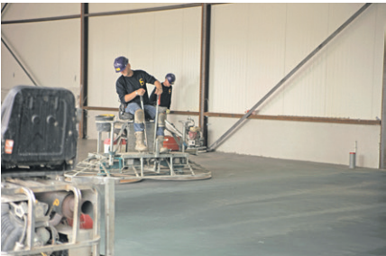
▲ In Deventer kon er al anderhalf uur na het storten worden gevlinderd.
