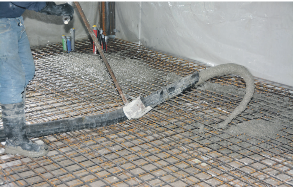
▲ ► Storten van de RAMAC-vloer.
