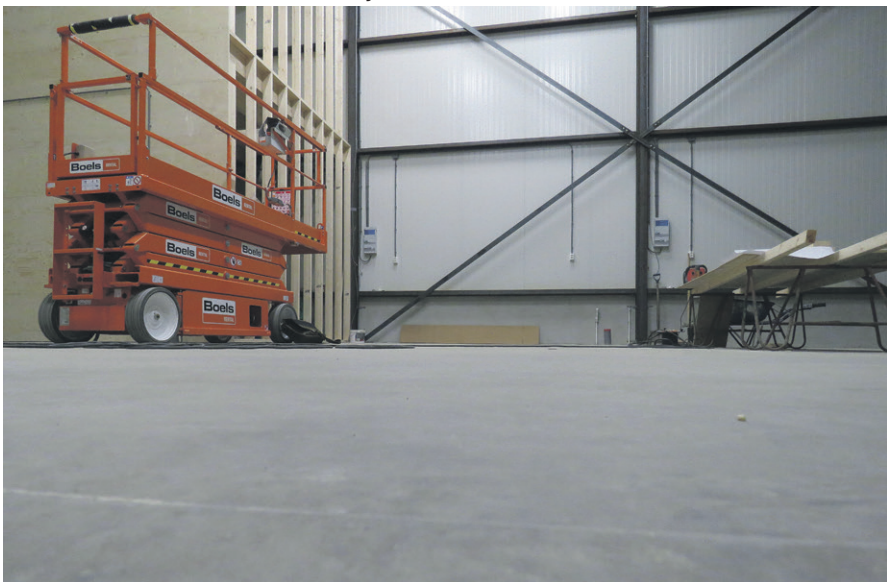
▲ Geen krimp scheuren rondom bijvoorbeeld stalen kolommen.
