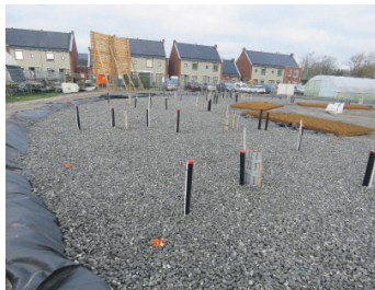
▲ De fundering bestaat onder meer uit 60 cm glasschuim.
