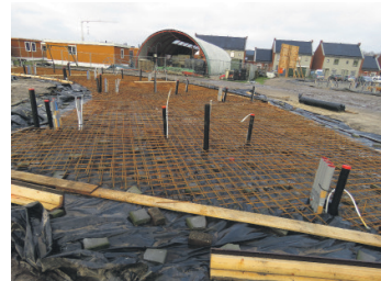
▲ Op het glasschuim is PE-folie aangebracht en de wapeningsnetten.
