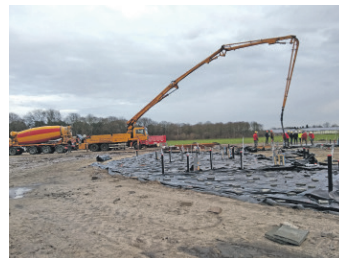
▲ Storten van de RAMAC-geopolymeervloer.
